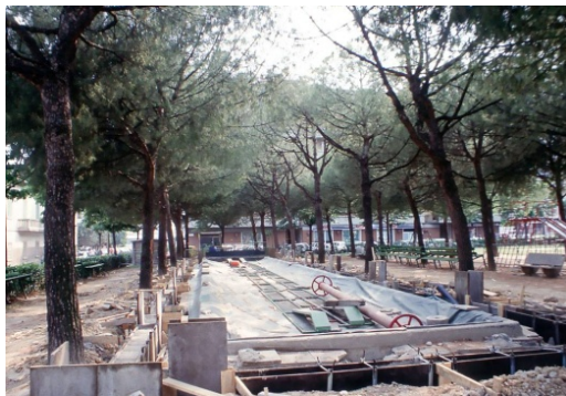
il pallaio in costruzione foto di Franco Banci
